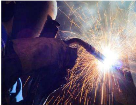
La soldadura y corte con soplete de gas Usa una llama para unir o cortar el metal.
