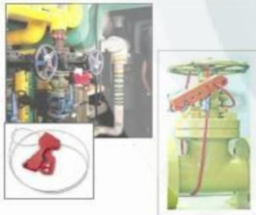
Bloqueo de valvulas de compuerta grande con bloqueo de cable flexible
