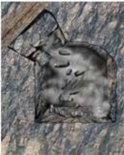
RIESGO Desprendimiento de Rocas
