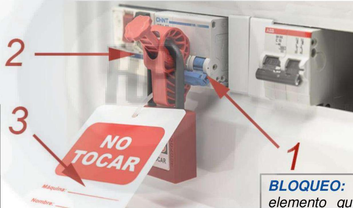
**BLOQUEO:** Se asegura que el elemento queda desenergizado, que se corta el paso a la energía viva.
