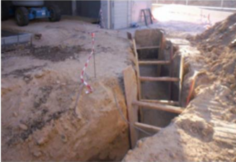
Entibación de madera (en desuso)
