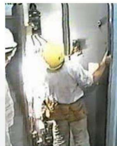
Lesiones- Arco eléctrico
