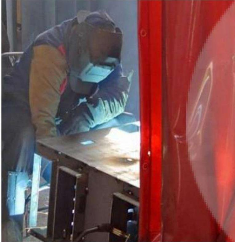
*Una cortina para soldadura protege a los empleados de la exposición directa a los rayos durante tareas de soldadura y corte por arco.*
