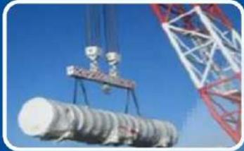
**ESTROBAR:** Se asegura la carga colocando estrobos, grilletes y eslingas
