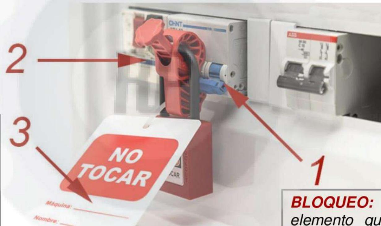
**BLOQUEO:** Se asegura que el elemento queda desenergizado, que se corta el paso a la energía viva.
