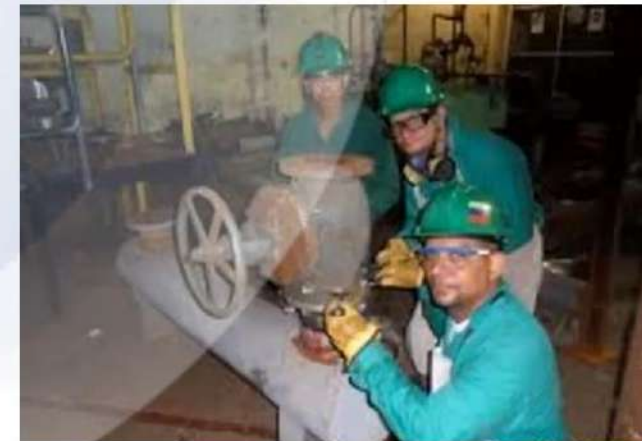
MONTAJE DE BRIDAS
