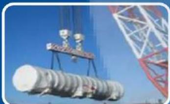
**LEVANTE PREVIO:** Solo se levanta si la carga esta balanceada correctamente
