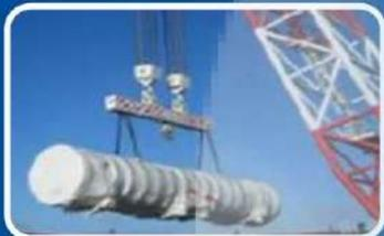
**TEMPLAR:** se tiemplan los estrobos y eslingas para verificar que la carga esta correctamente asegurada
