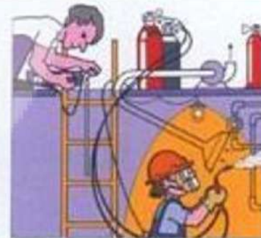
Control desde el exterior de la situación, durante todo el tiempo de trabajo, con medición continua de la atmósfera interior.
