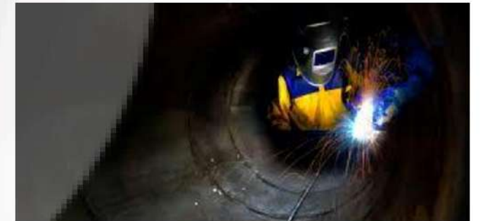
Sujeto a acumulación de contaminantes.
